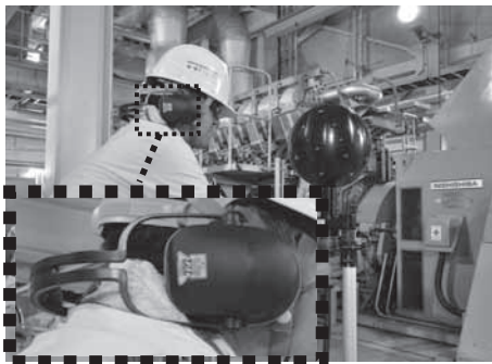
図7 音源探査機材設置状況
