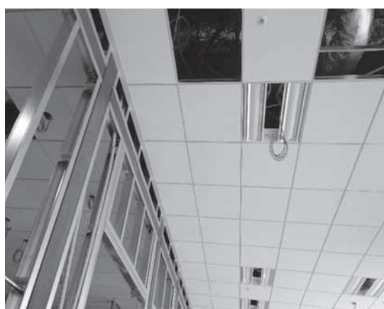
施工後の仕上り状態
