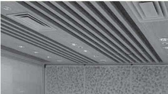
写真8 天井 ピンホールパネル+リブ組合せ事例
