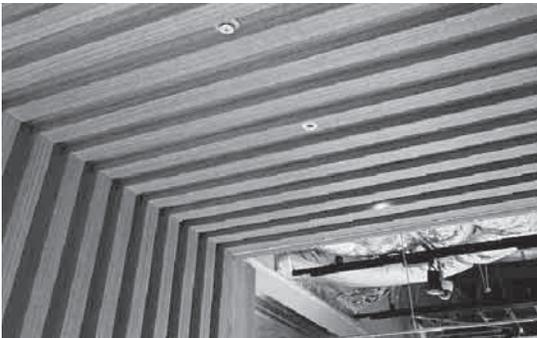
写真7 壁 天井 ピンホールパネル+リブ組合せ事例
