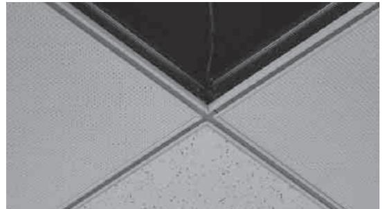
写真9 システム天井納まり事例
