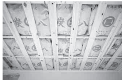
写真4 天井用調湿木炭敷設状況
