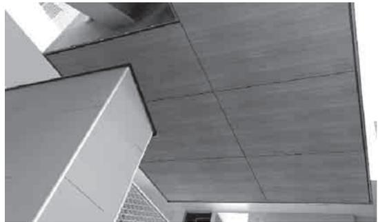
写真2 接着工法による天井施工例
