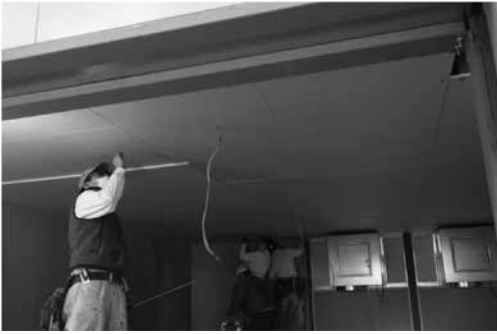
写真4 防音室施工状況
