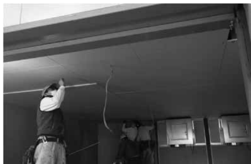
写真4 防音室施工状況
