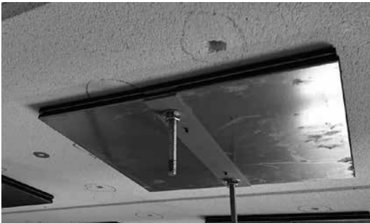
写真1 制振材付ダンパー(床下面固定タイプ)
