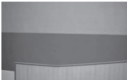
写真9 ガラスクロス施工
