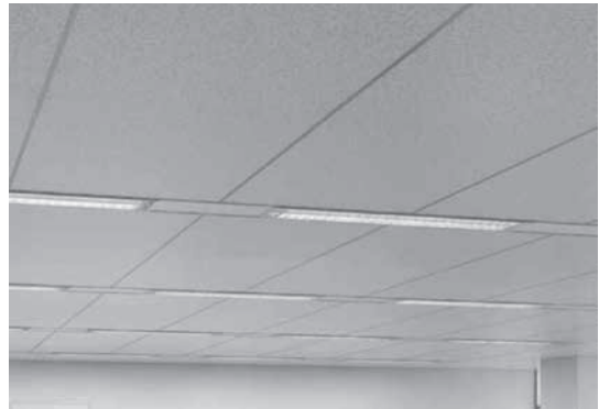
写真13 オフィス施工例
