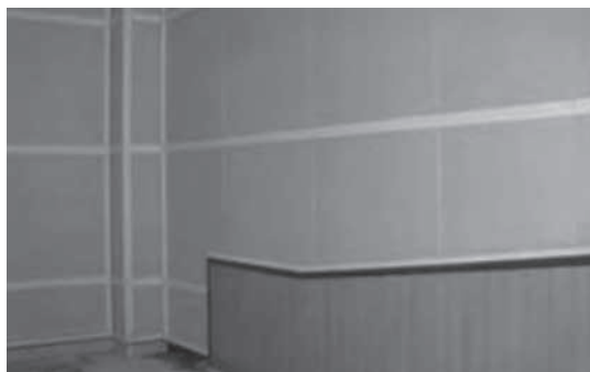
写真7 ジョイナー施工
