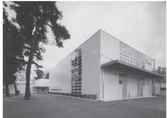
写真6 建築音響試験室棟 1)
