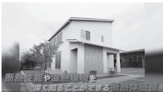
写真1 断熱体感棟パラマン館
