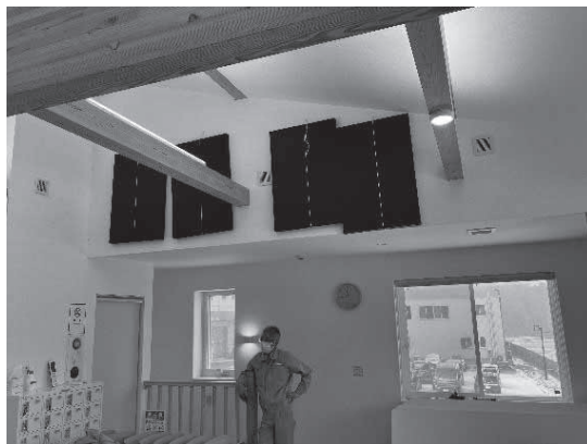
写真7 パラマン館2階研修室 東壁上部のGCボード設置状態
