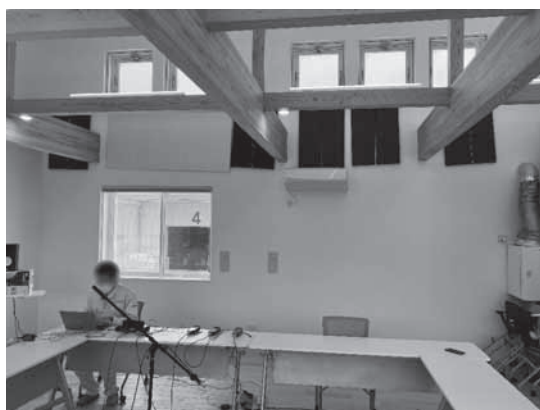
写真8 パラマン館2階研修室 北壁上部のGCボード設置状態
