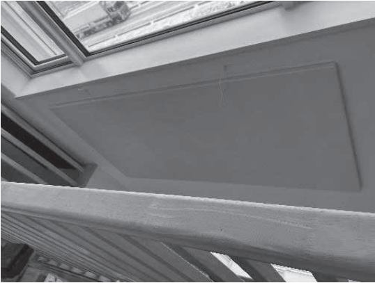
写真10 パラマン館2階研修室 吹抜けのGCボード設置状態
