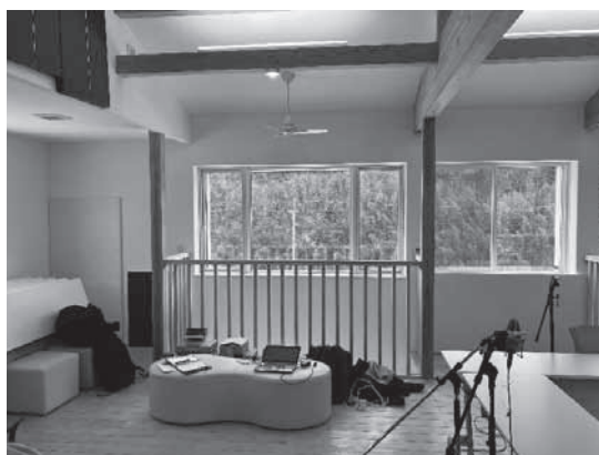
写真9 パラマン館2階研修室 南壁のGCボード設置状態
