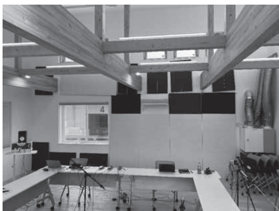
写真6 断熱体感棟パラマン館2階研修室 北壁のGCボード設置状態
