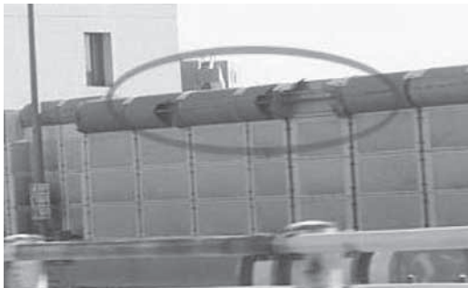
図1 従来型の破損状況例
