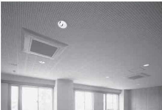
写真1 音楽教室での施工事例
