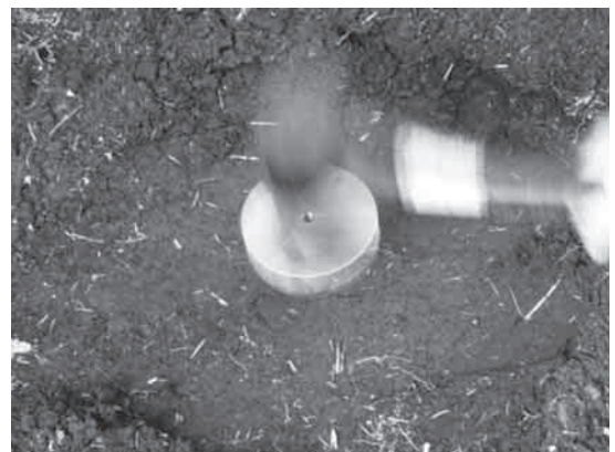
図2 1本杭PU支持具(打ち込み時)
