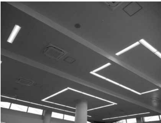
写真2 イージーセーフ工法 体育館
